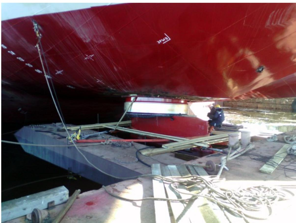
Рисунок 2. Винто-рулевая колонка фирмы Azipod в понтоне проекта P05A в процессе установки на судно
