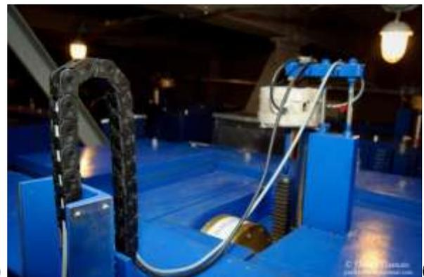
*Рисунок 6.32 – Массовые демпферы с обратной связью, установленные внутри пролетных строений*
