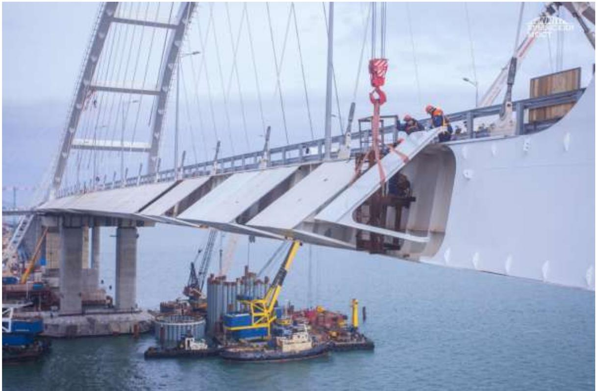
*Рисунок 6.48 – Установка обтекателей, разработанных в Крыловском центре, на автодорожную арку Крымского моста*
