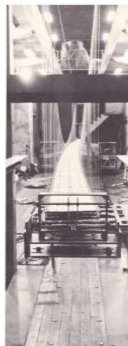
*Рисунок 1.15 – Фотографии деформации модели моста при аэроупругих колебаниях*
